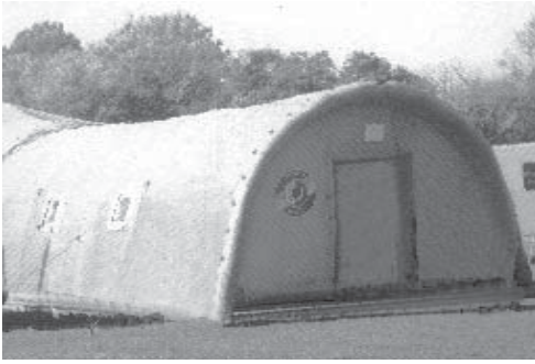
Рис. 2.21. Підрозділ госпіталю, який розвернуто у пневматичних модулях: а) вид зовні; б) вид усередині.
