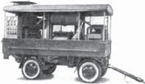
Рис. 4.4 б. Крупорушка причіпна ПКРМ.
